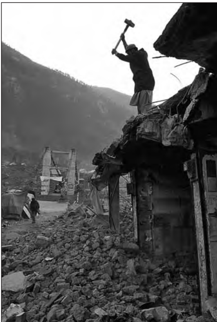
Hela staden slås sönder i små bitar med släggor för att komma åt armeringsjärn, tegel, sten etc.
