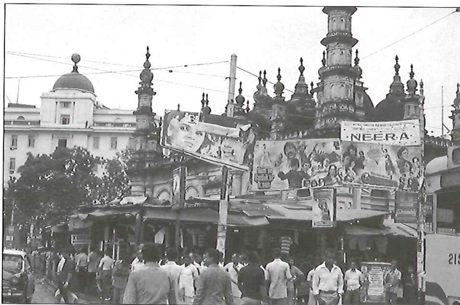
En typisk bild från Calcutta, där under decennier gatuhandlare tagit över trottoarerna. Nu har den kommunistiska regeringen beslutat ändra på den bilden. I en spektakulär aktion har tusentals bodar rivits med bulldozrar.
