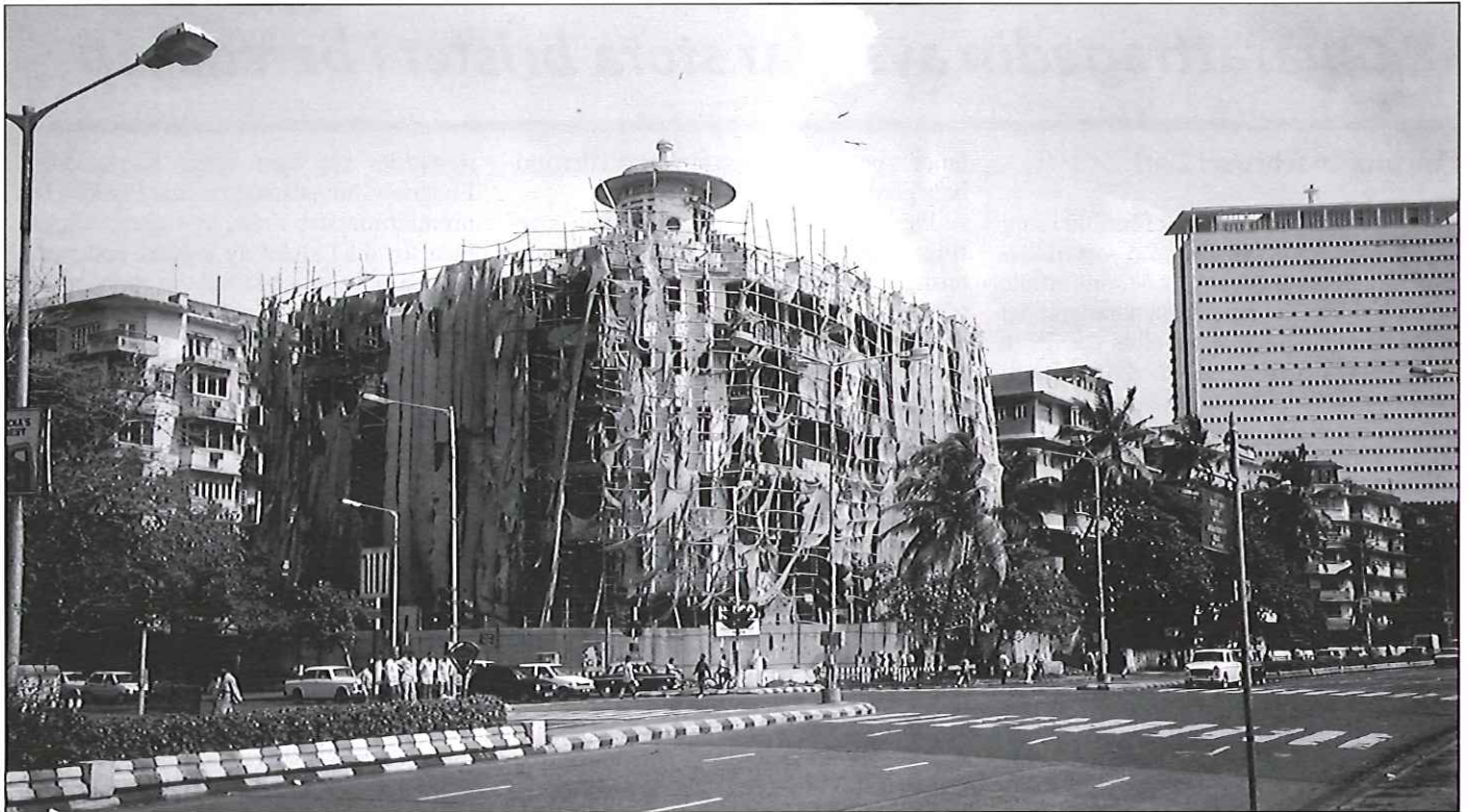
Med stålrör och betongförstärkning kan byggnader förhindras från att rasa vid ett skalv. Men många byggherrar struntar i dessa viktiga men dyra metoder. Här pågår ett husbygge längs Marine Drive i Mumbai.
