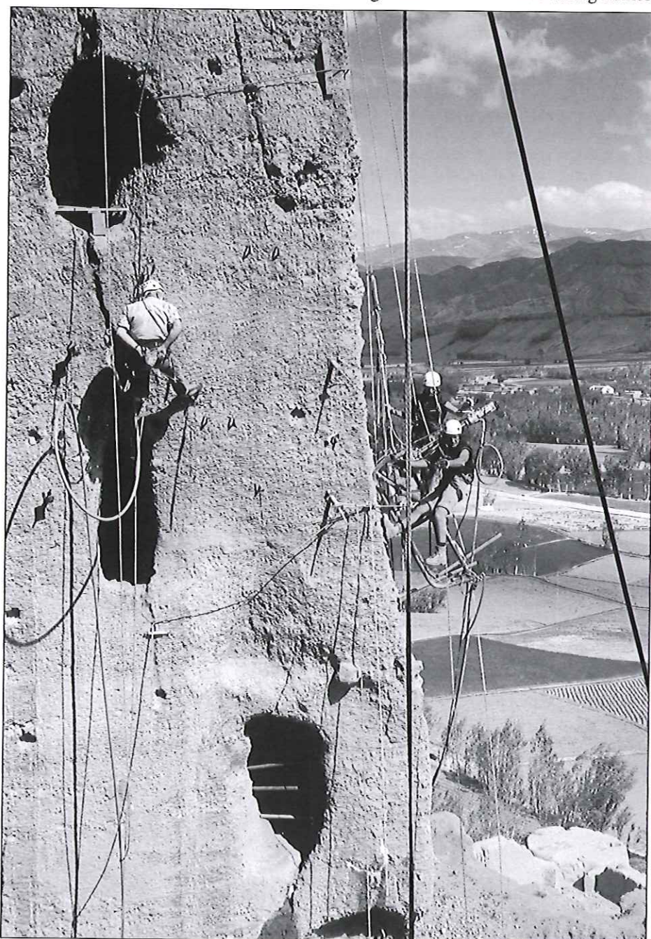
Gianni, Fabio och Luigi är alpinister. De har hyrts in för att rädda det lilla som räddas kvar av buddhorna. Buddhansscherna och det omgivande berget hotas av sprickor och håligheter som uppstod efter talibanernas attacker.
