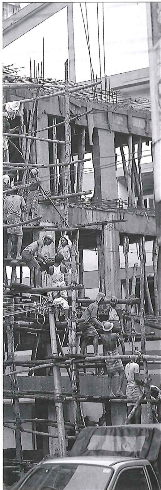
Här arbetar hantlangare på ett bygge i Panjim i delstaten Goa.
